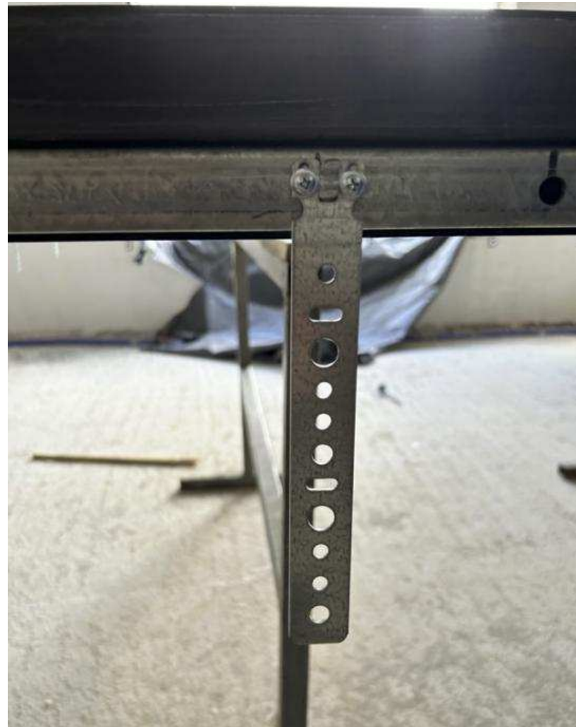
2.3-сурет – Терезе жақтауына анкер пластиналарын орнату
