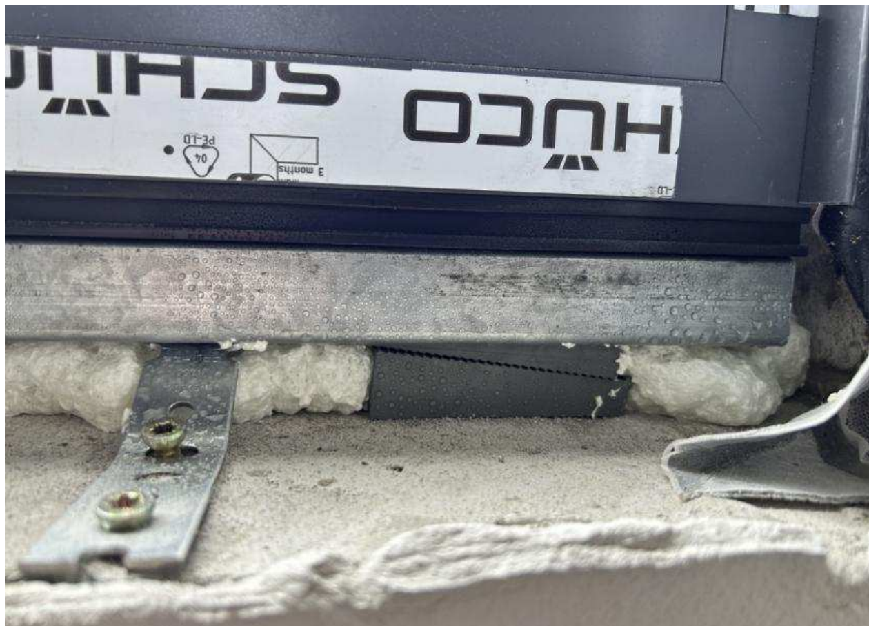
2.7-сурет – Сыртқы гидроокшаулағыш таспаны жапсыру және тігісті монтаж көбігімен тығыздау
