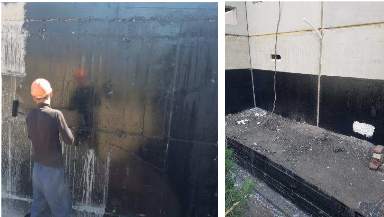
4-сурет – Гидроокшаулау мастиканы жағу
