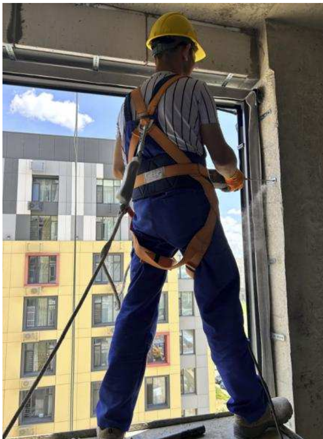
2.6-сурет – Терезе жақтауын бетонға монтаждау
