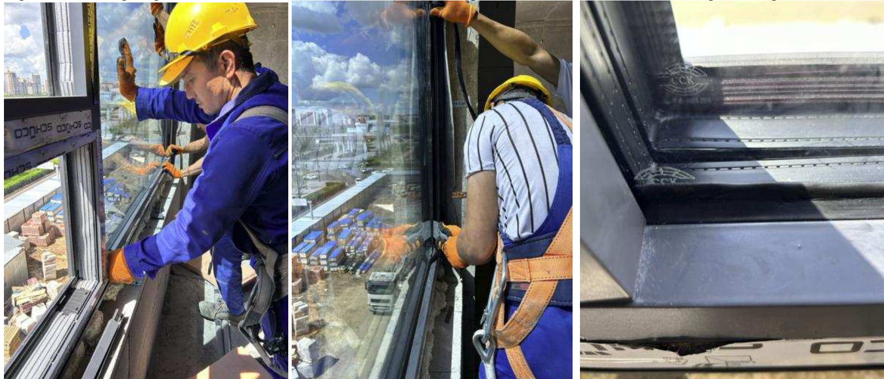
2.9-сурет – Штапиктер мен нығыздаушы резеңкені орнату
