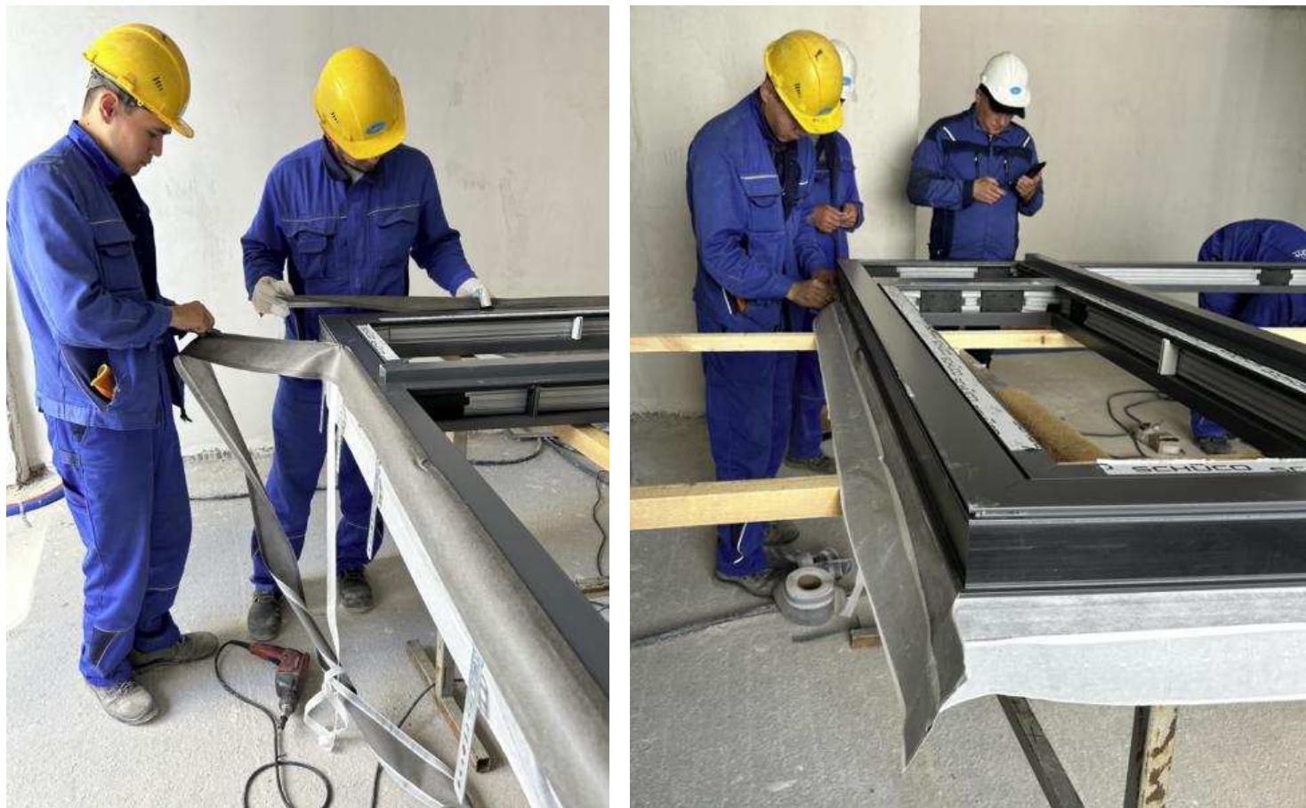
2.2-сурет – Ішкі және сыртқы гидрооқшаулағыш таспалардың жапсырмасы
