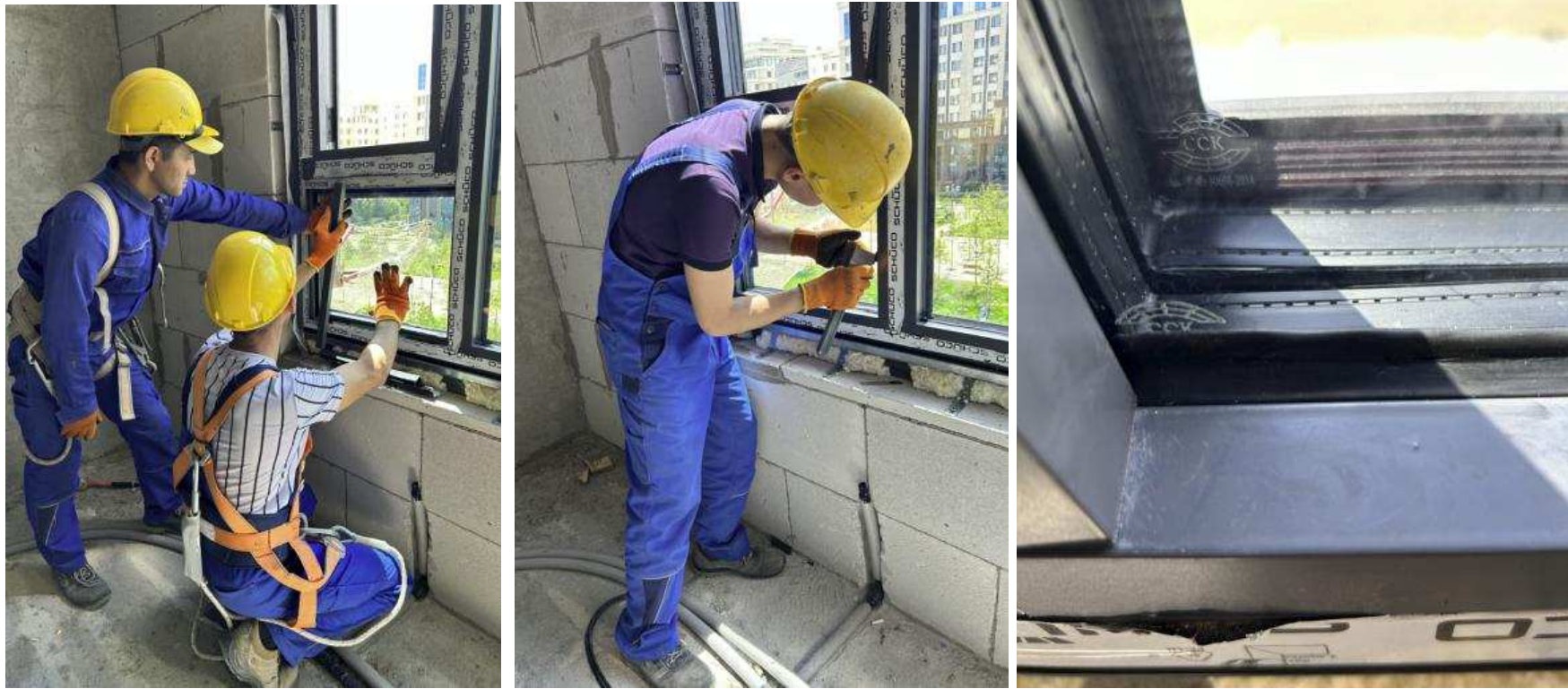
2.9-сурет – Штапиктер мен тығыздағыш резеңкені орнату
