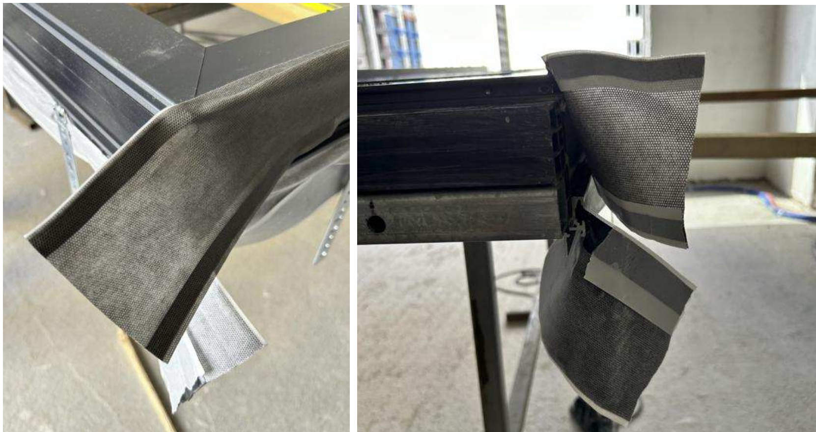
2.2-сурет – Ішкі және сыртқы гидрооқшаулағыш таспалардың жапсырмасы
