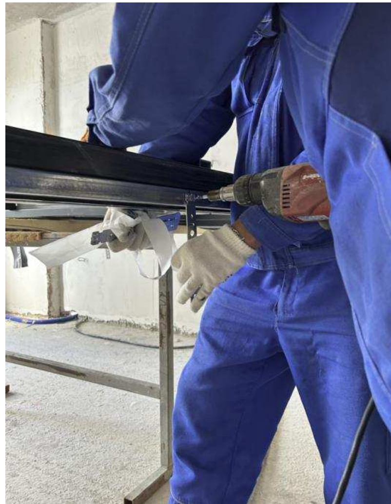
2.3-сурет – Терезе жақтауына анкер пластиналарын орнату
