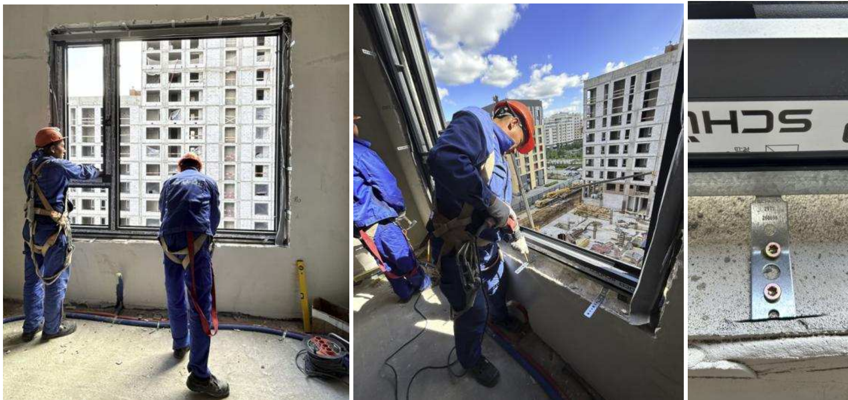
2.6-сурет – Газоблок терезе жақтауын монтаждау
