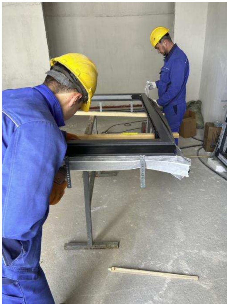
2.3-сурет – Терезе жақтауына анкер пластиналарын орнату
