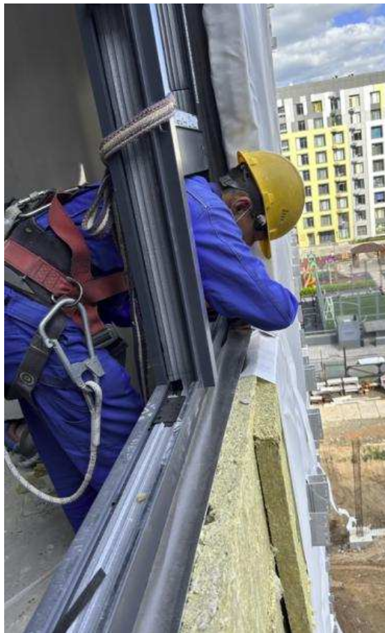
2.7-сурет – Сыртқы гидроокшаулағыш таспаны жапсыру және тігісті монтаж көбігімен тығыздау
