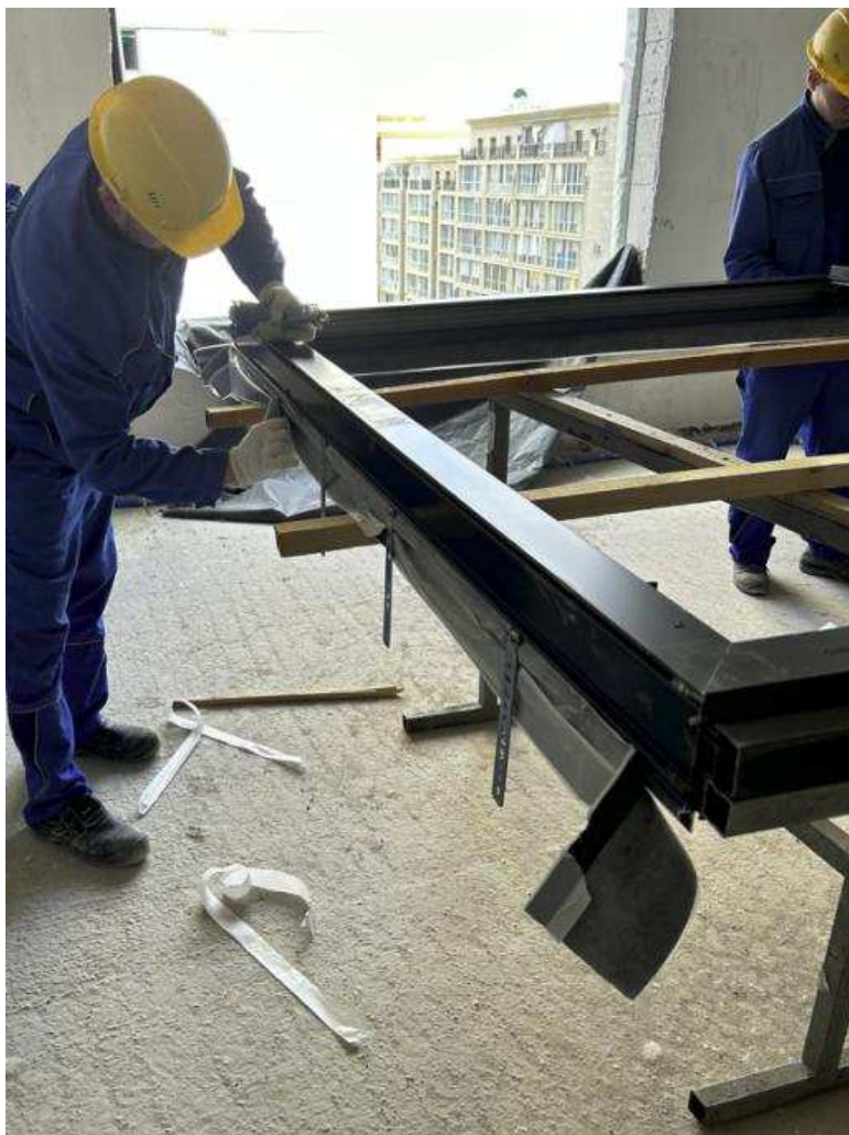
2.3-сурет – Терезе жақтауына анкер пластиналарын орнату
